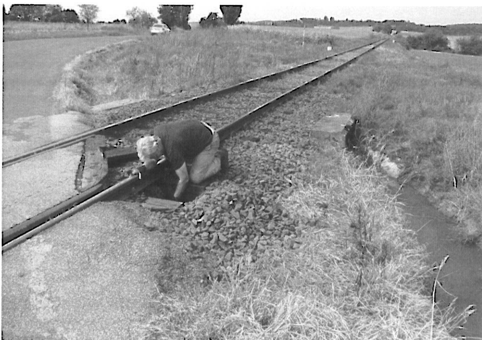
Pohled na otevřený nezpevněný příkop zaplněný srážkovou vodou (viditelné i čelo propustku pod trati)
