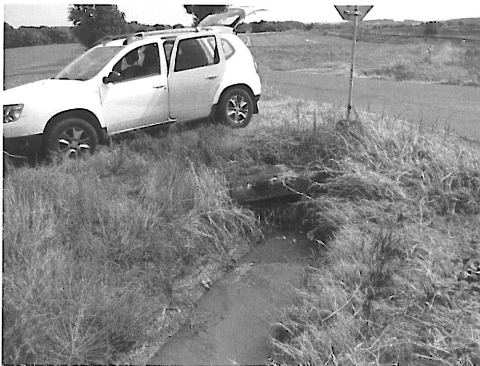
Pohled na navazující poškozený propustek krytý pískovcovými deskami
